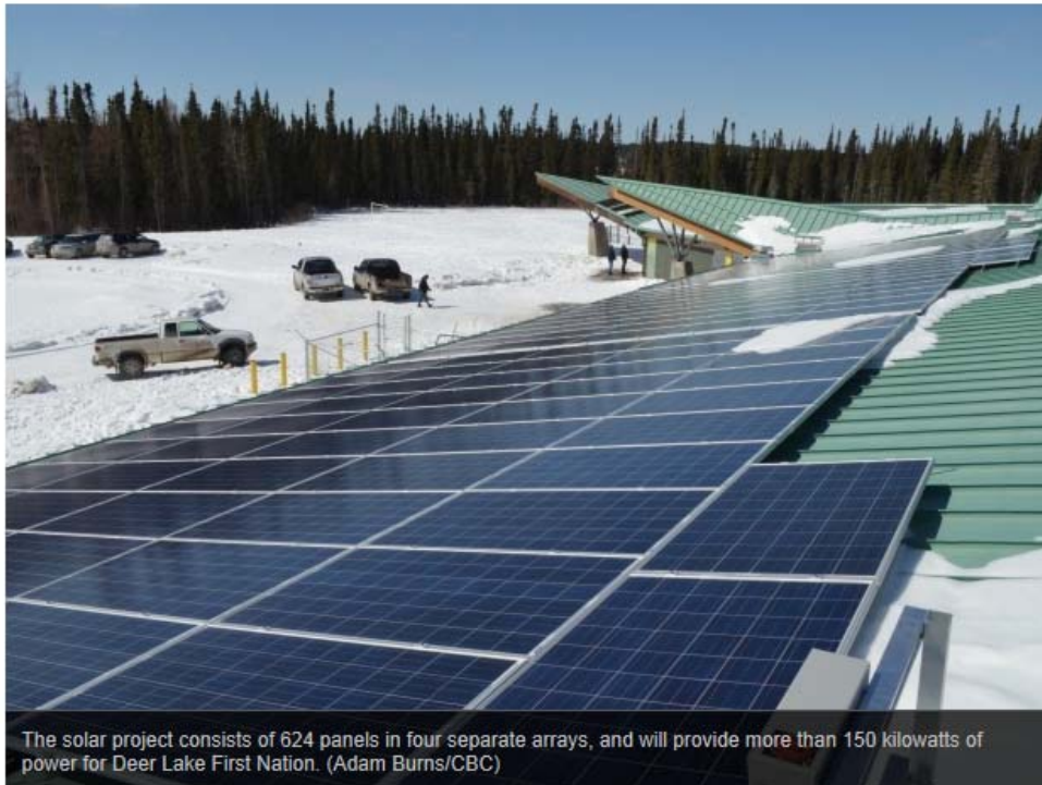
Figure 6 : Photo du projet solaire de la Première Nation de Deer Lake (source : CBC News) 104
